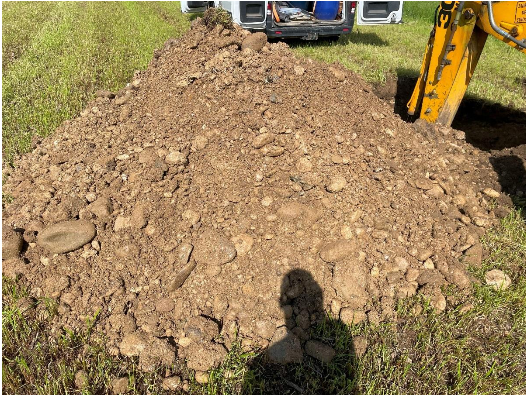
Slika 7: Sondažni izkop SI 2: izkopani material
